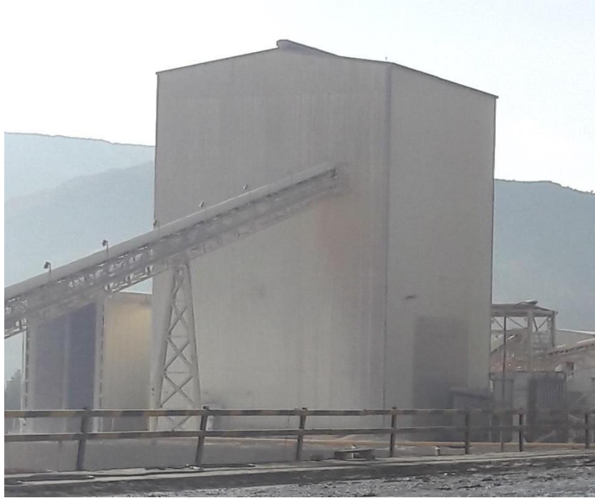
شکل شماره ۲۴: انتهای نوار ۴۱ و ساختمان سنگ شکن ثانویه
