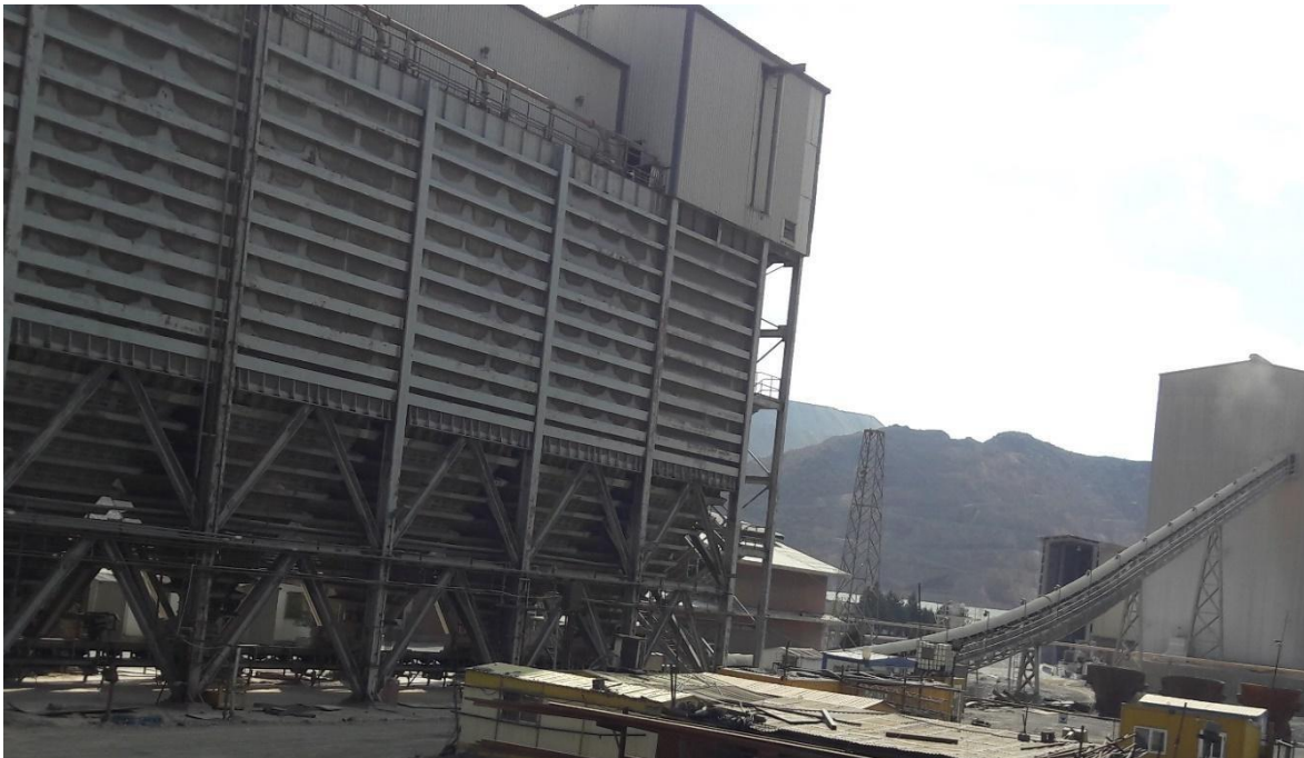
شکل شماره ۲۵: نمای کلی مخازن هشت گانه و نوار ۴۱ و سنگ شکن ثانویه
